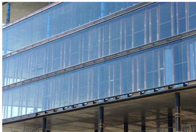
Façade view Erste Group Wien // © Henke Schreieck Architekten, Vienna
